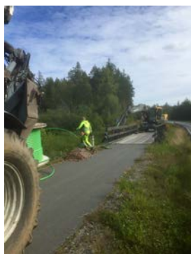
Fiber byggs ut till Hook
