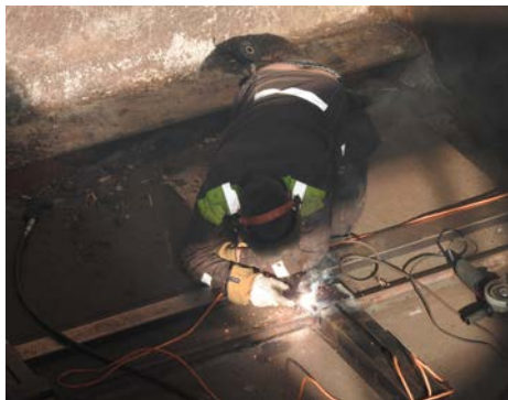
Revisionsarbete inom fjärrvärmern
