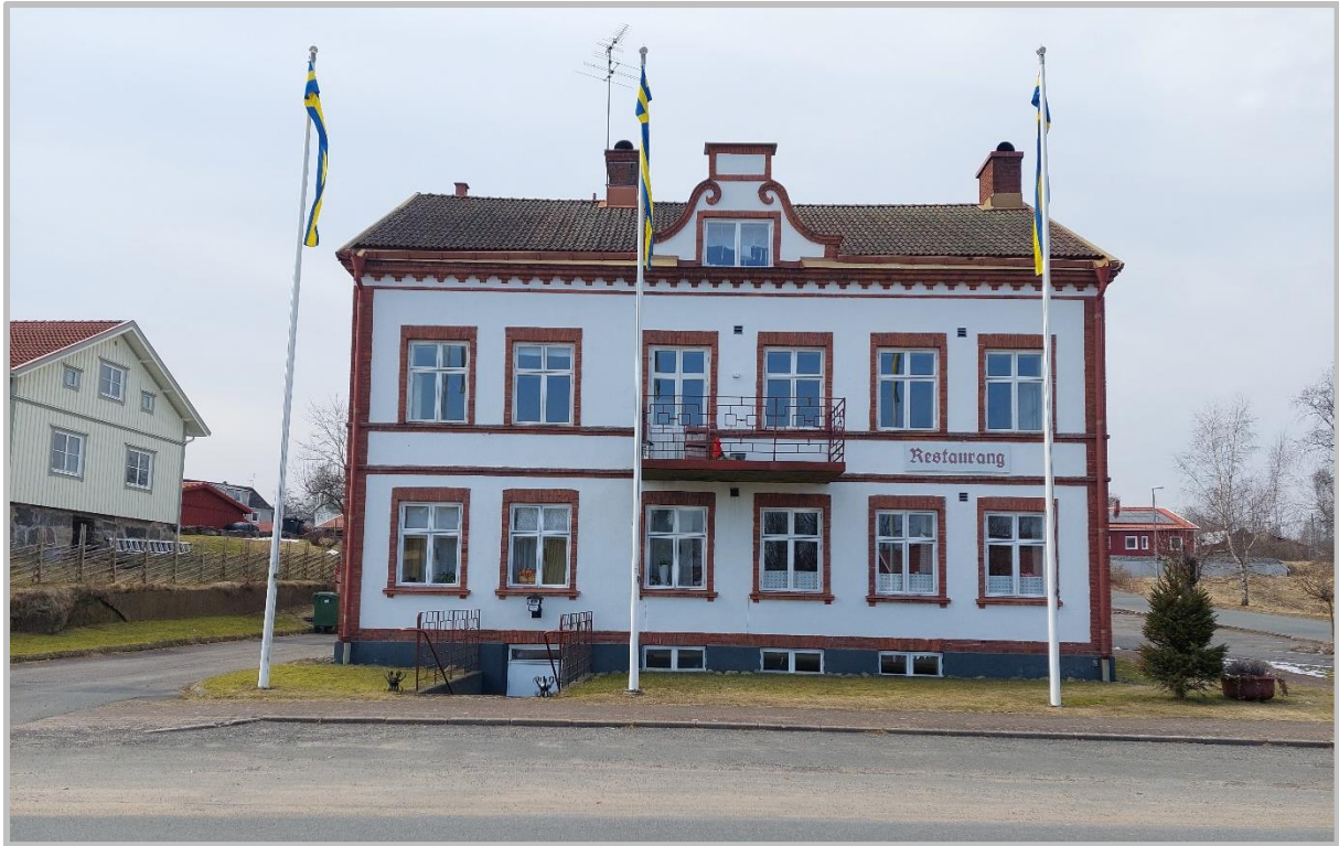
Figur 10: Angränsande byggnad på fastigheten Tomaten 8 som ingår i den kommunala kulturmiljön.
