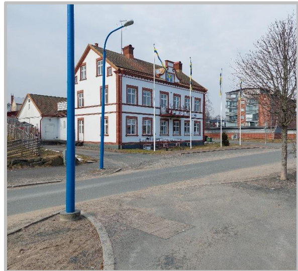
Figur 9: Angränsande byggnad på fastigheten Tomaten 8 som ingår i den kommunala kulturmiljön.
