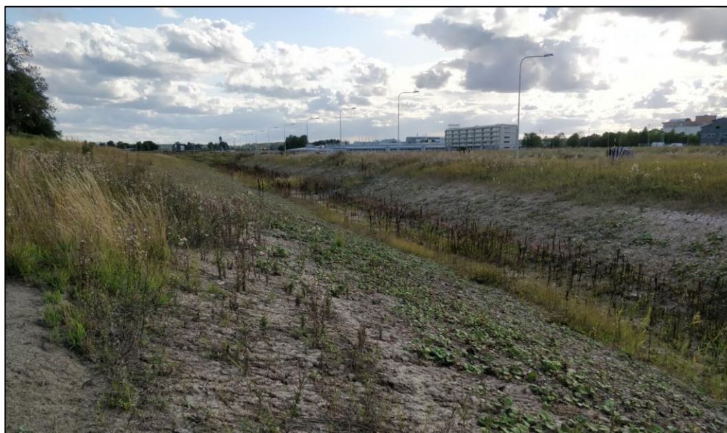
Figur 16. Exempelbild på svackdike (Foto: Sweco).
