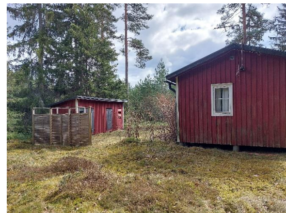
Figur 6: Obebott bostadshus med komplementbyggnad
